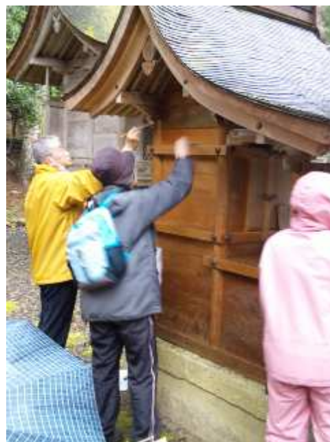
柿渋を塗る作業
